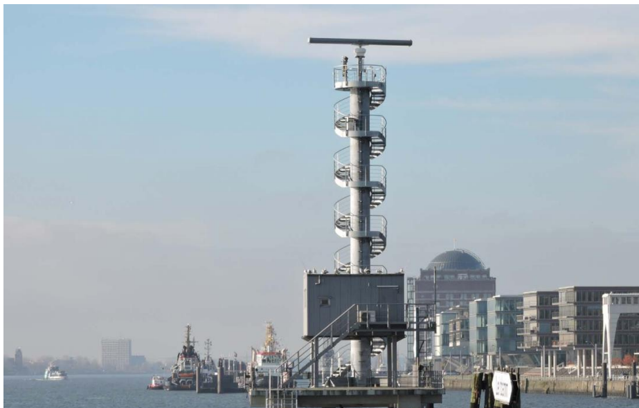
Slika 49: Prikaz primera postavitve daljinsko vodenega radarja za nadzor pomorskega prometa v Londonu (VTS&CS v izvedbi TERMA – Scanter 5000)
