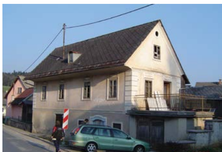
Slika 25: Stanje hiše pred rušitvijo. Avtor: Jože Strniša.
