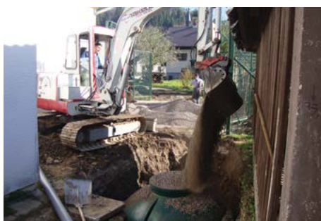
Slika 20: Primera gradnje rastlinske in mehanske MKČN. Vir: Razvojna agencija Sora d.o.o.
