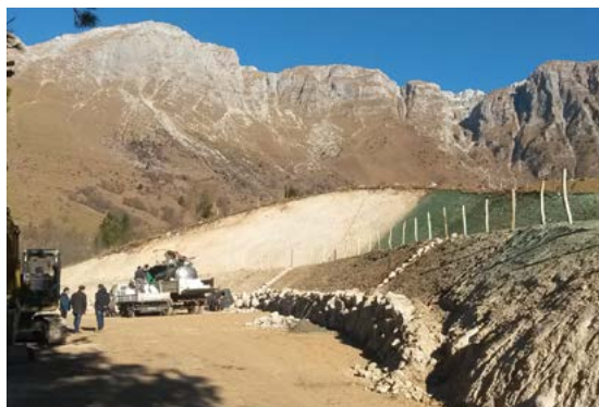
Slika 29: Gradnja parkirišča pri planini Kuhinja. Avtor: Marko Lavrenčič.
