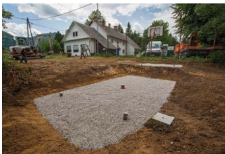
Slika 19: Primera gradnje rastlinske in mehanske MKČN. Vir: Razvojna agencija Sora d.o.o.
